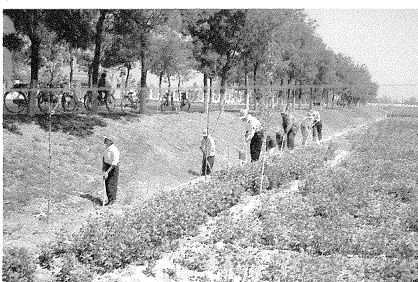
道工正在修整“文明样板路”
